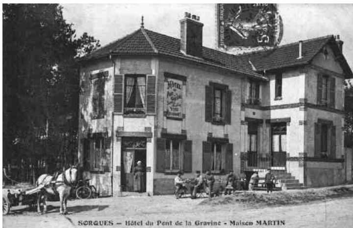
SORQUES - Hôtel du Pont de la Gravine - Maison MARTIN
